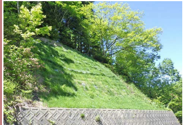
施工事例① 施工後6ヶ月
