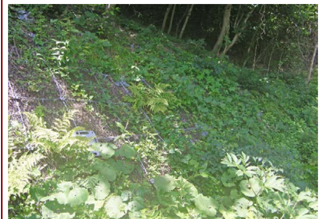
施工事例② 施工後5ヶ月
