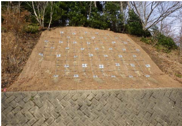
施工事例① 施工直後
