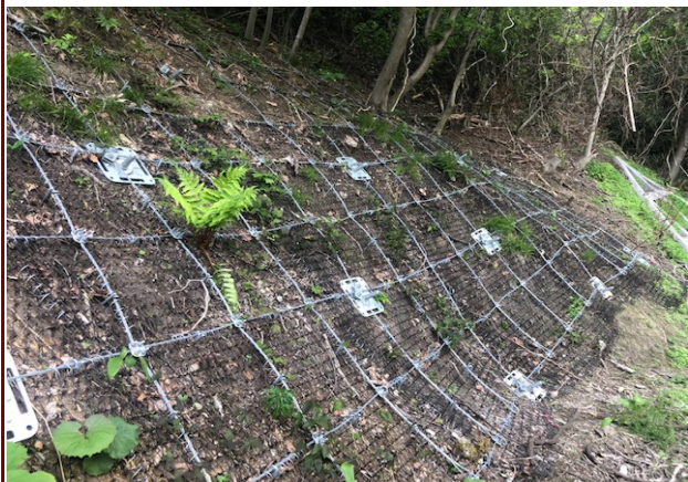
施工事例② 施工後2ヶ月
