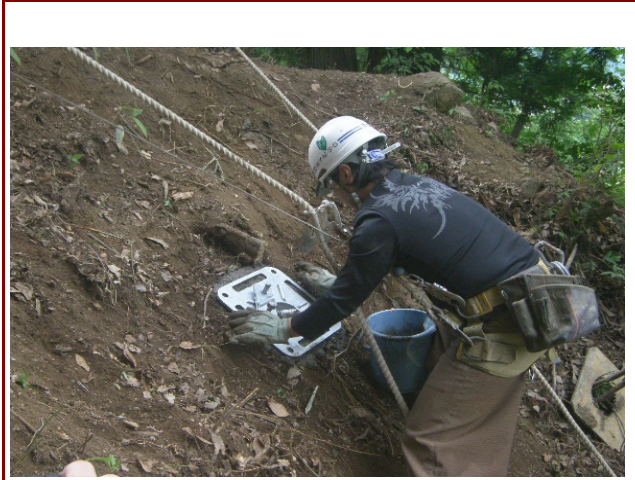
施工状況 受圧板設置工
