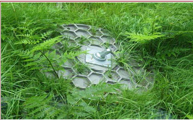
施工完了事例
