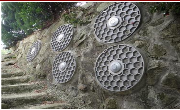
施工完了事例
