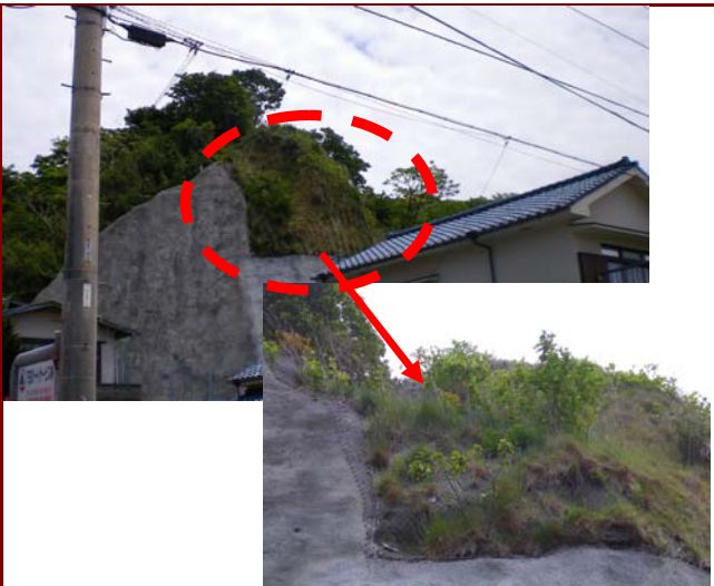
県内事例;急傾斜地(下田土木事務所管内)
