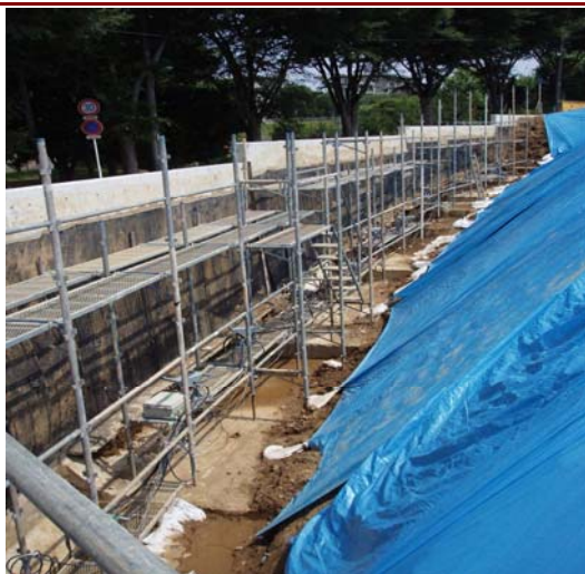
L型擁壁復元注入事例
