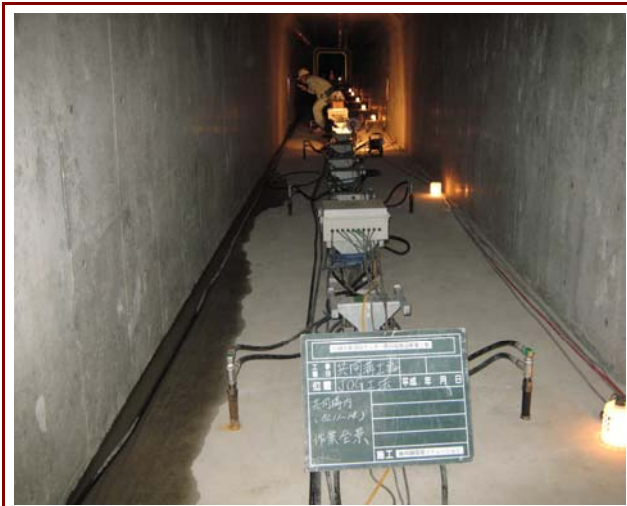
BOXカルバート復元注入
