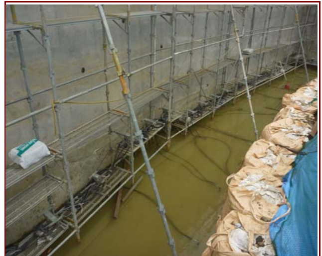
L型擁壁復元注入
