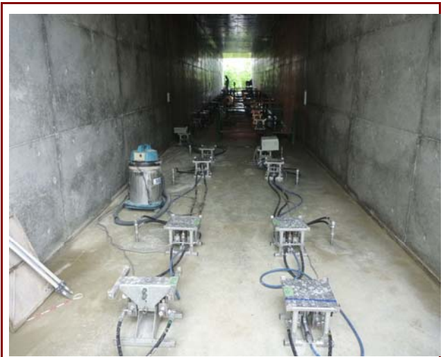
BOXカルバート復元注入
