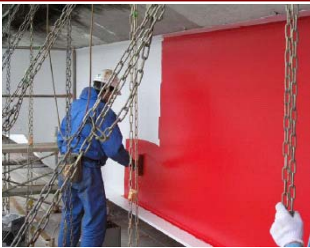
ユニテクト30SFの塗装状況
