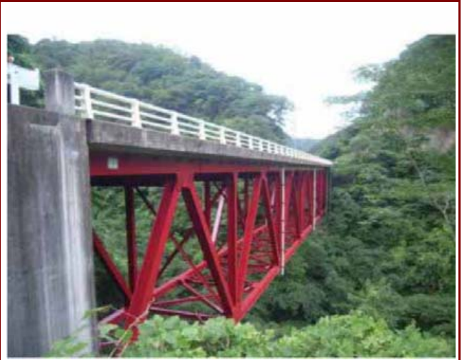
施工実績 浜田線安養寺橋塗替工事
