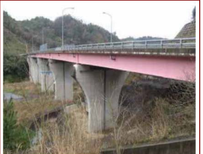
施工実績 国道191号笹倉大橋塗替工事
