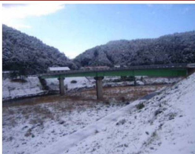
施工実績 野田線杉の森橋塗替工事
