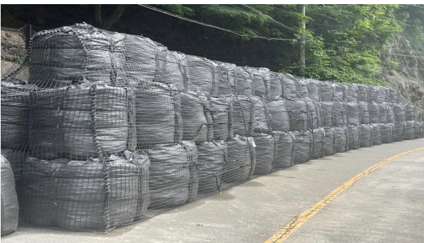
施工完了事例
