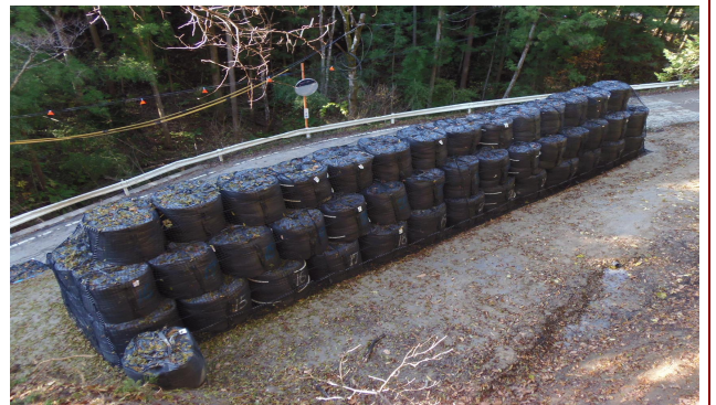
施工完了事例
