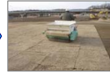
目土散布(平坦地)
