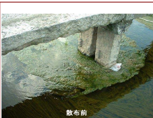
用水路 施工前(02'11.7)
