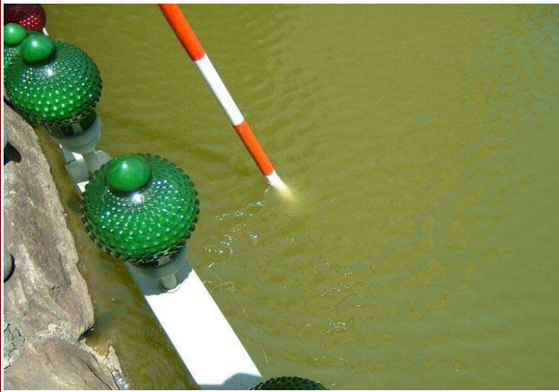
チボリ公園池 施工前(04'6.22)
