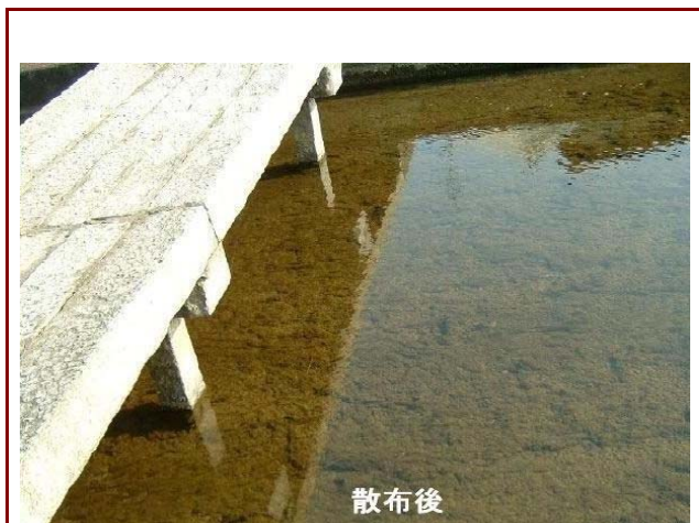
用水路 施工後(02'1.7)
