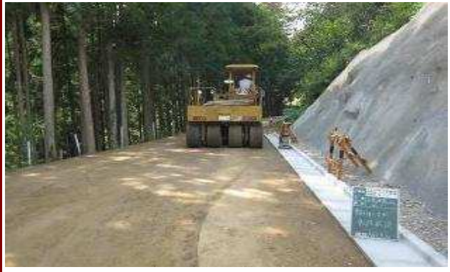
上層路盤材 転圧状況
