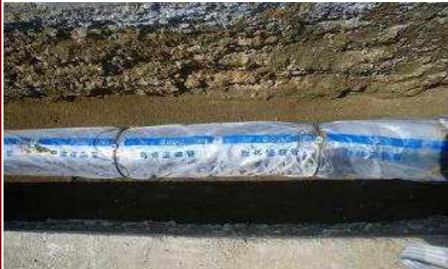
管巻材(路体材) 施工状況
