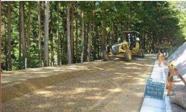
上層路盤材 敷均し状況
