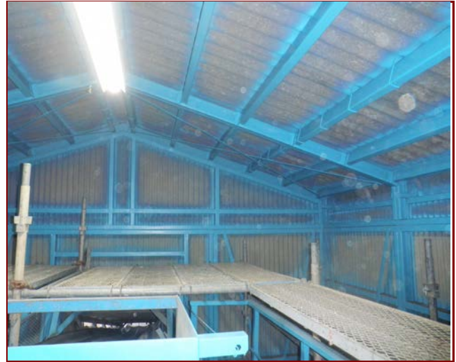
ミナト生コン小屋天井重防錆工
