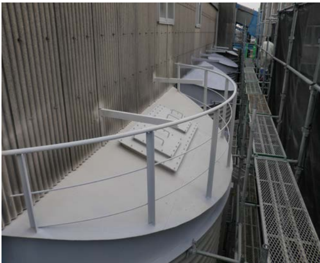
ミナト生コンコルゲイトサイロ重防錆工
