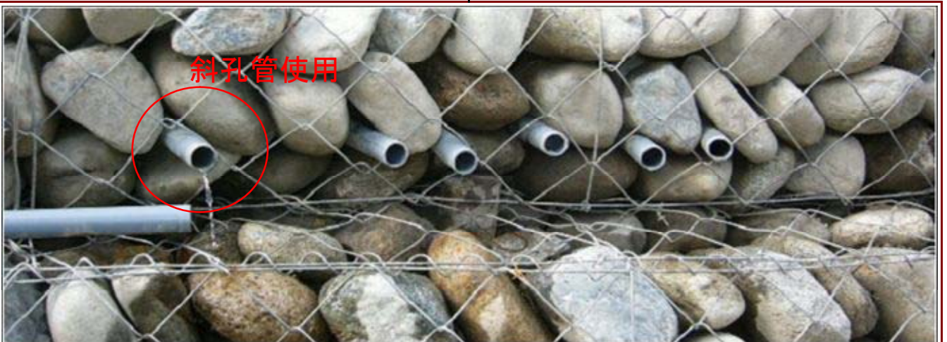
斜孔管地すべり対策現場例2
