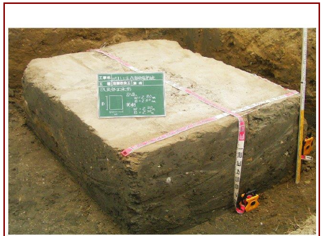
改良体掘出し確認
