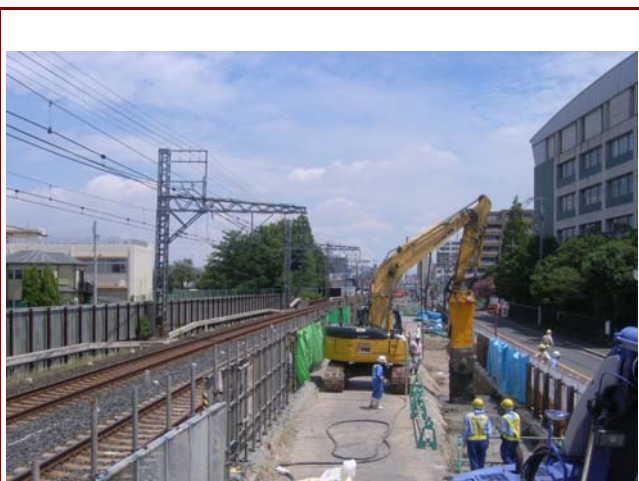
鉄道近接施工
