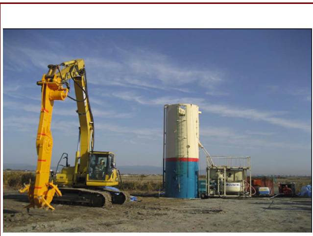
施工機とプラント全景
