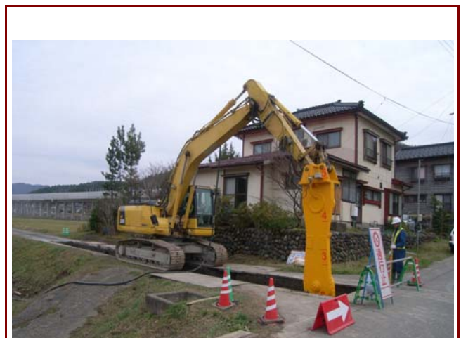
既設構造物近接施工
