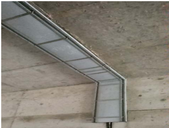
施工前(従来工法)
