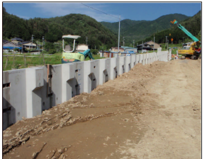
埋め戻し状況
