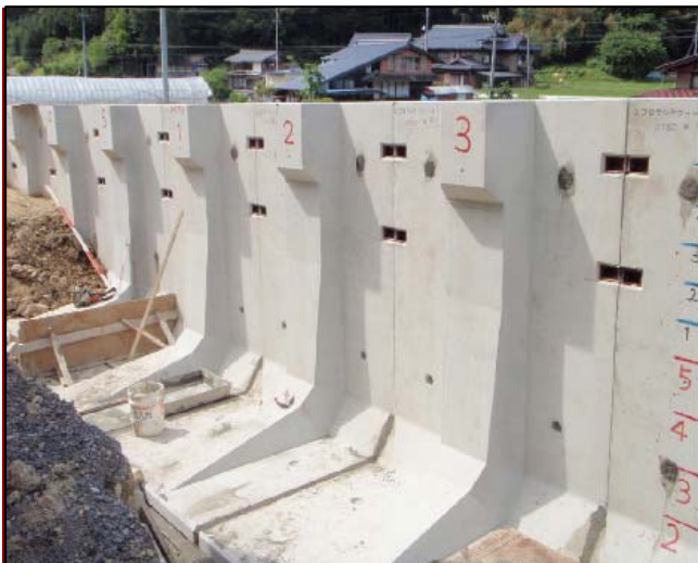
製品据付状況
