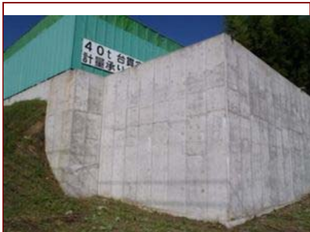
施工完了状況①
