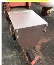
1層目:カーボマスチック15J (70μm)
