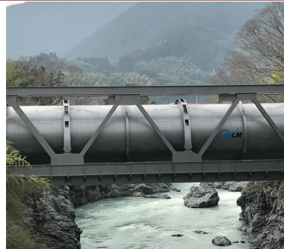
施工実績 水管橋
