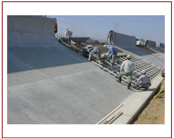
河川堤防に対する適用事例
