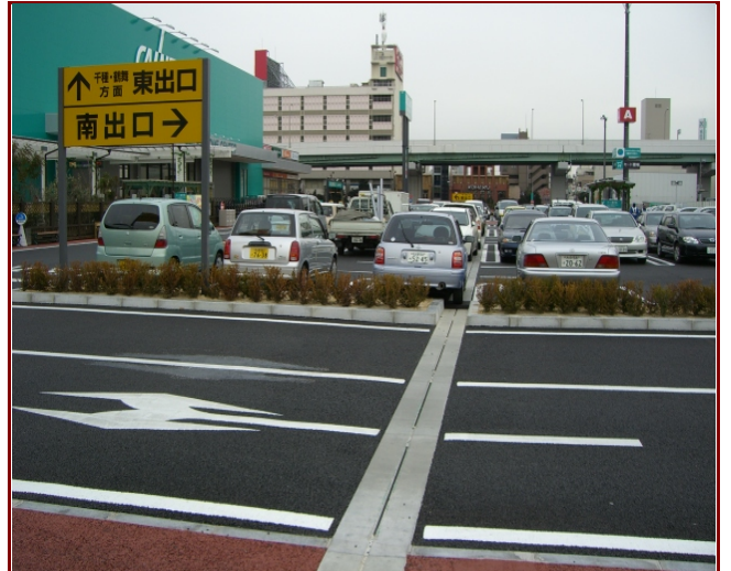
民間 可変施工現場
