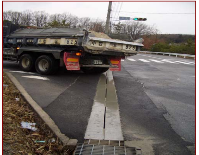
緊急維持工事 横断施工
