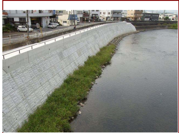
平成19年度黄瀬川大岡護岸災害復旧工事
