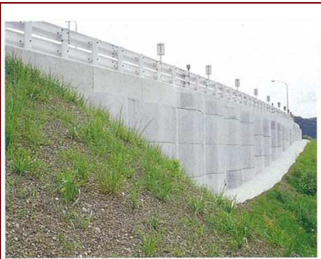
事例1:長大盛土法面での国道拡幅
