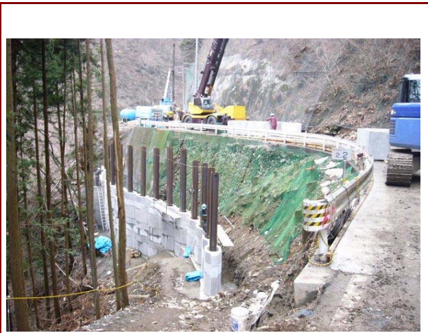
施工中の親杭パネル壁工法による道路拡幅
