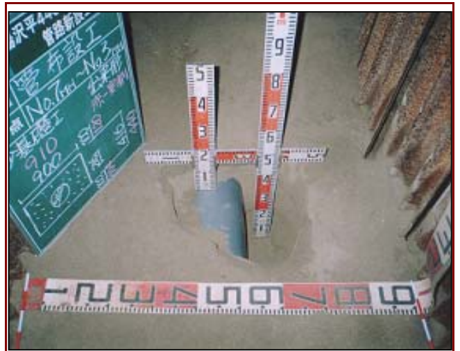
下水道管 埋設状況(富士市 - クッション砂)
