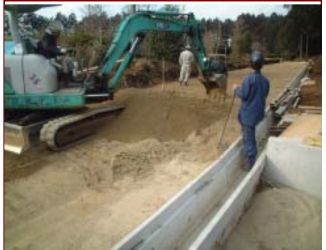
HBサンド敷き均し(富士市道 - 路床)
