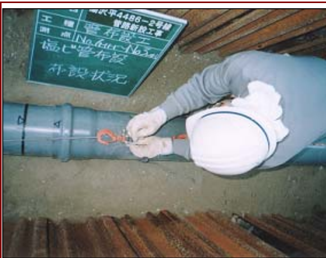
下水道管 布設状況(富士市 - クッション砂)
