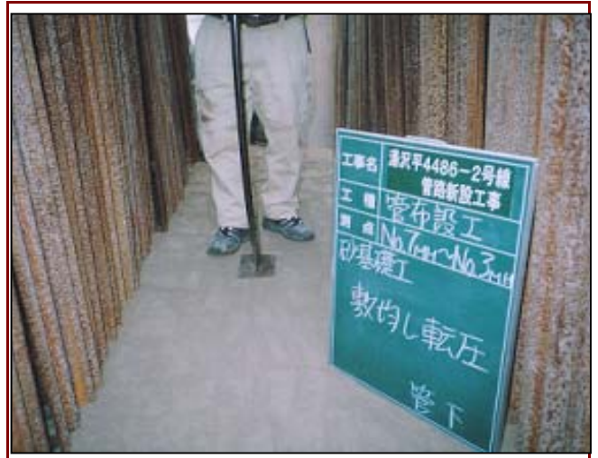
下水道管下敷均し転圧(富士市 - クッション砂)
