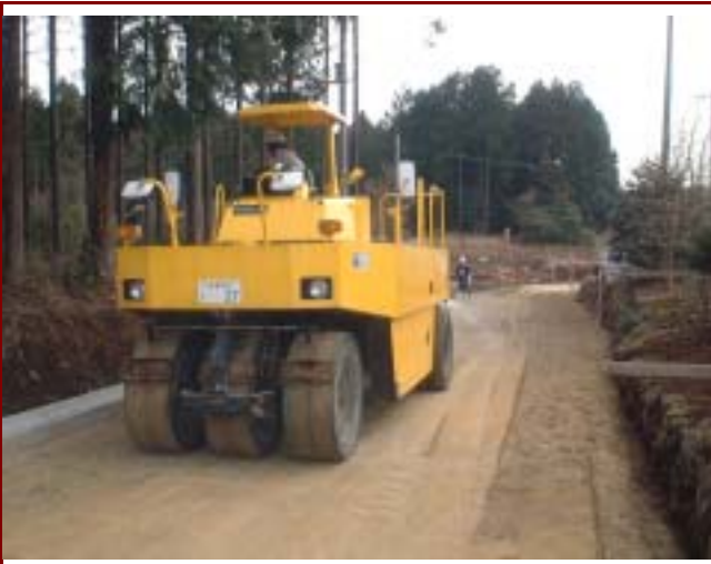
HBサンド散水・転圧(富士市道 - 路床)
