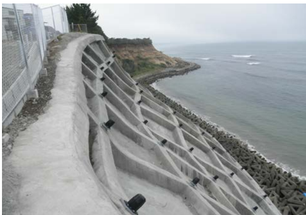
施工実績写真-1
