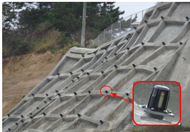
施工実績写真-2
