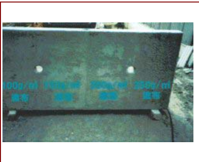
蒸気養生後の型枠脱型面
