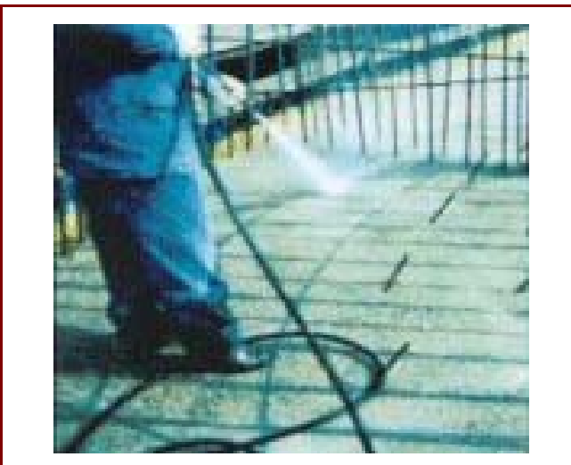
高圧水による処理状況
