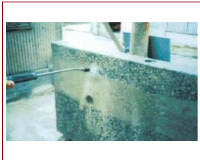
蒸気養生後の高圧水による処理状況
