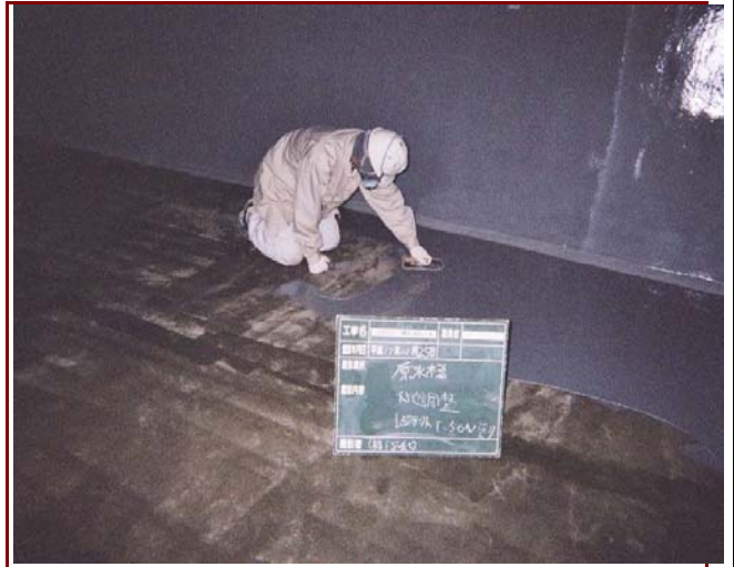
プライマー塗布
