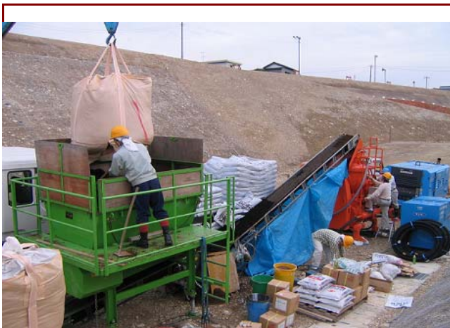
施工プラント一式
