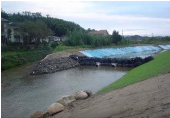
H19.2京都府奥山川河川改修工事
