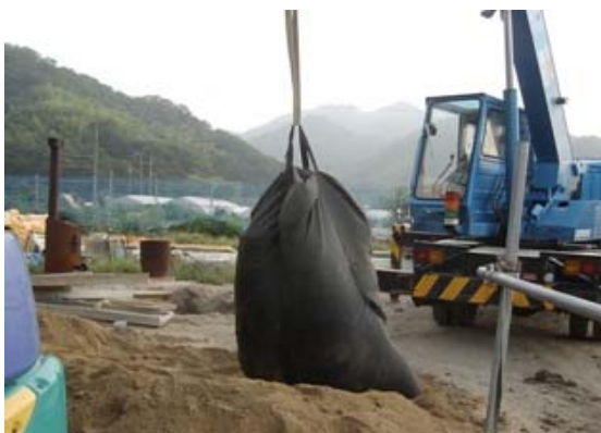
工場内:土砂取り出し試験(再利用)
