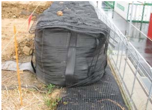
H18年度四日市港霞ヶ浦北埠頭地区地盤改良工事
