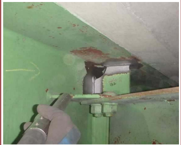
ショットピーニング施工状況
