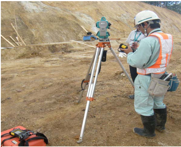
現場測量風景
