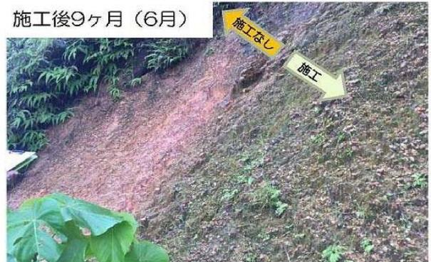
林道法面崩壊箇所での試験施工状況(国立公園内)
