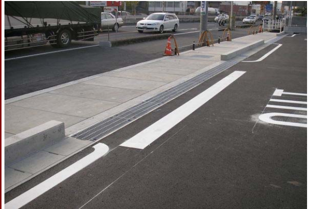
横断用 現場施工例
