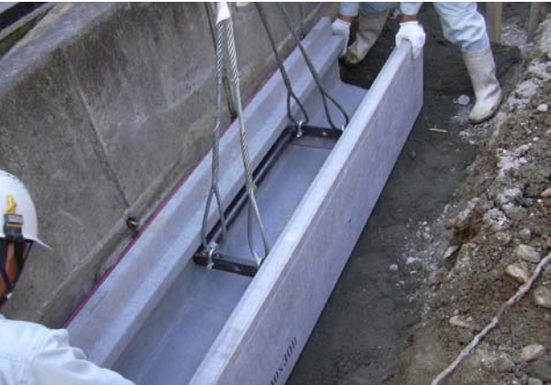
境界施工状況
