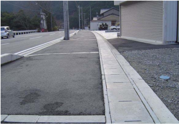
縦断用 現場施工例
