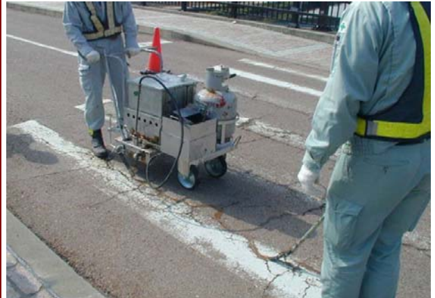
カラーシールNの注入(クラックシーラ)
