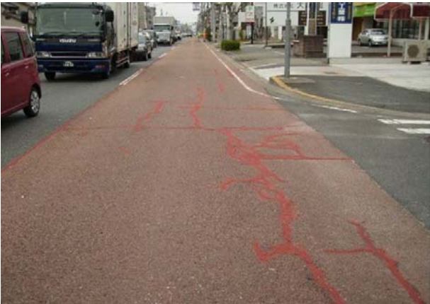
カラーシールN(クリアタイプ)施工後
