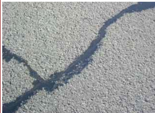
一般のクラックシール施工後
