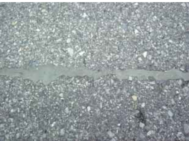
カラーシールN(グレータイプ)施工後
