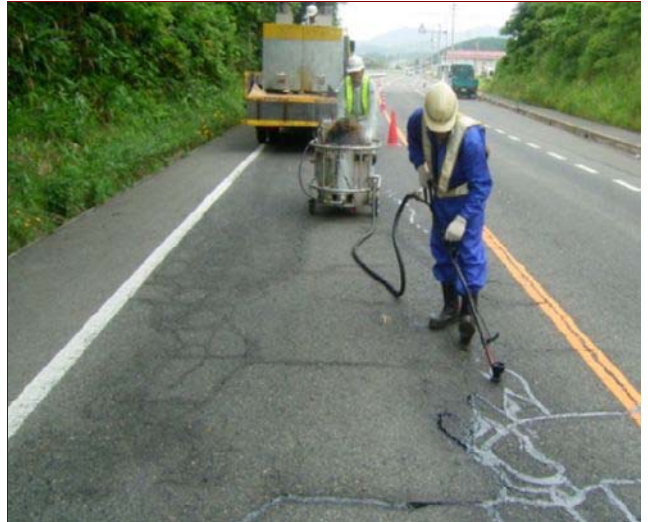
クラックシールNX施工状況
