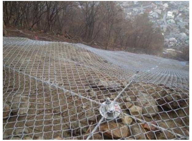
施工事例(金網併用)
