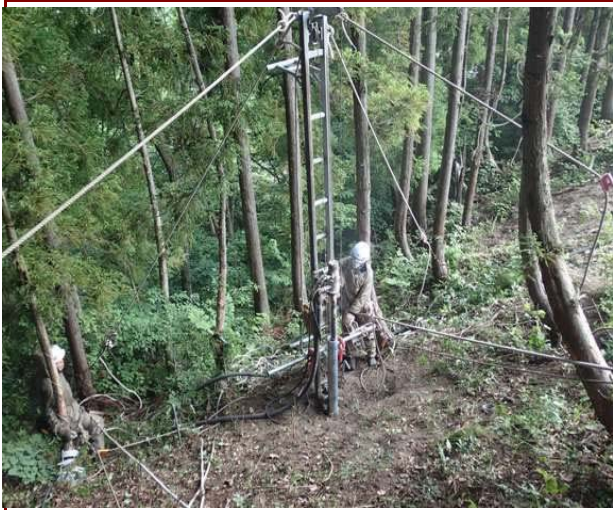
MF杭設置状況
