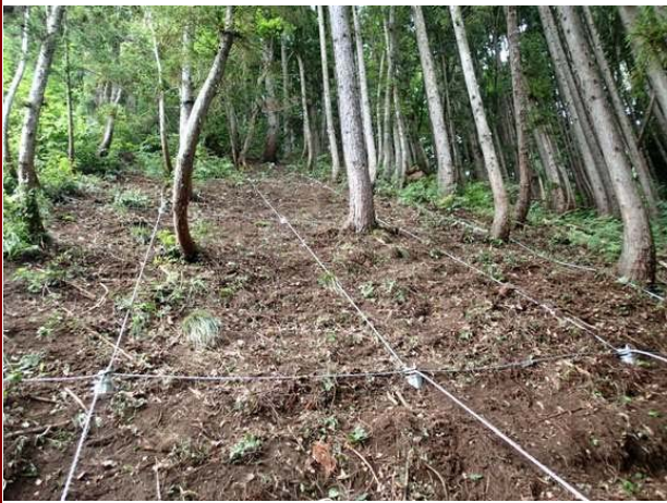
施工事例(正面)
