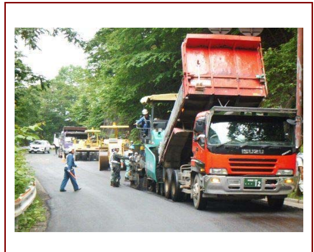
クリーンファルトII型:施工状況
