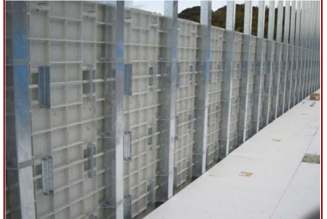
軽量残存型枠実施工 (EPS・和歌山県海南IC)
