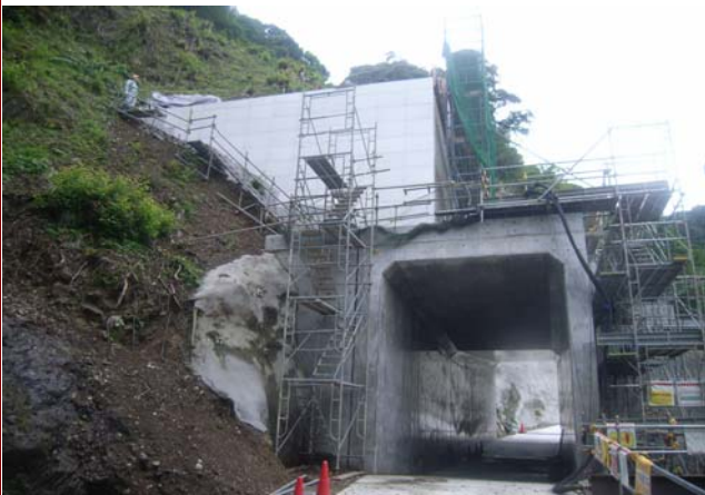
軽量残存型枠実施工 中部横断自動車道湯沢第一トンネル工事 静岡県静岡市清水区葛沢～中河内
