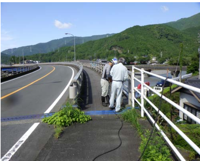
新気田川橋梁全景(試験)
