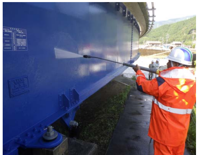
新気田川橋洗浄作業(試験)
