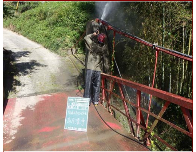
瀬居橋洗浄作業
