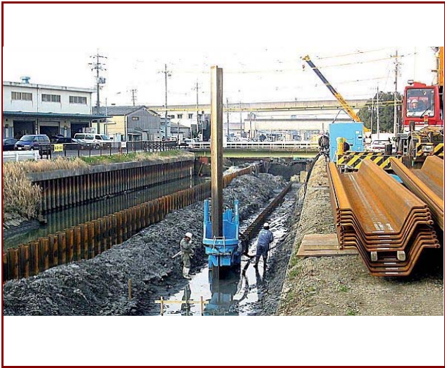
水路改修工事に適用 (ハット形鋼矢板)
