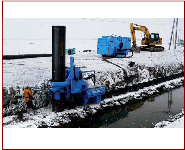
排水路護岸工事に適用 (ハット形鋼矢板)
