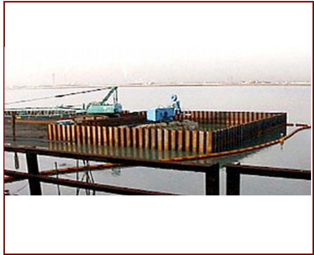
養殖場近傍での施工事例
