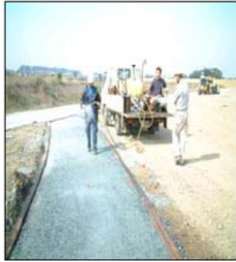
下地散水(下地とパワーサンドの密着性を良くする)
