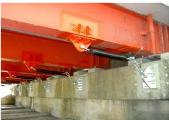
建築限界対策として吊り上げて設置例
