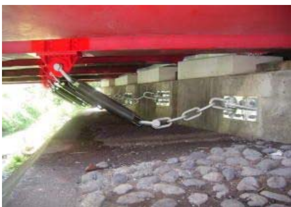
鋼鉄桁橋に緩衝チェーンを設置した例
