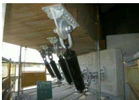
鋼箱桁橋に緩衝チェーンを設置した例
