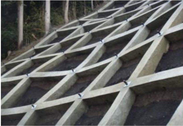
AS345-Pボルト施工完了例写真1
