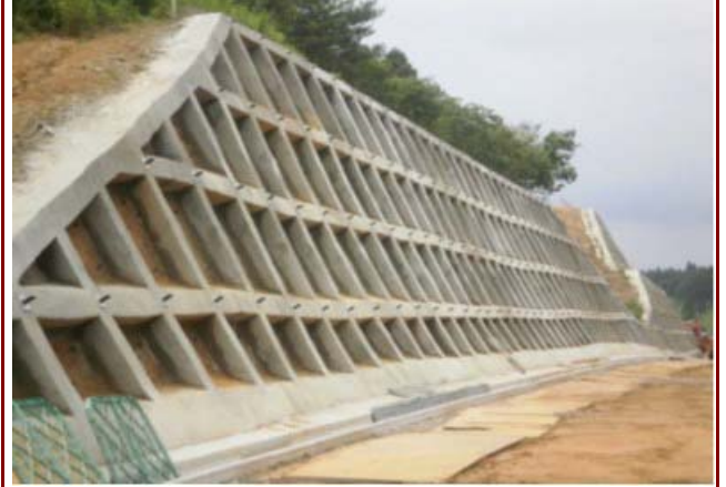
AS345-Pボルト施工完了例写真2
