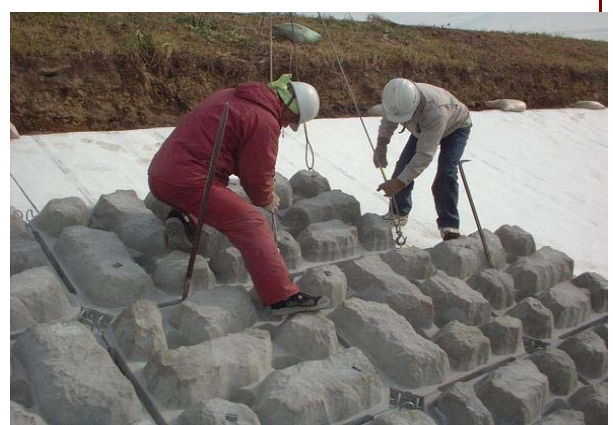
グリーンデコ施工状況
