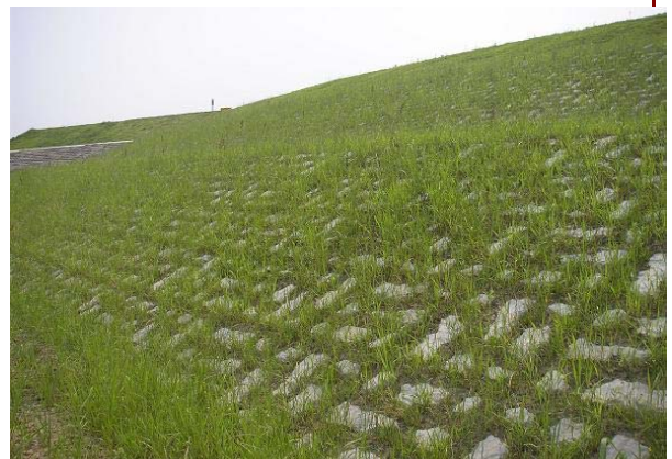
グリーンデコ施工数年経過後
