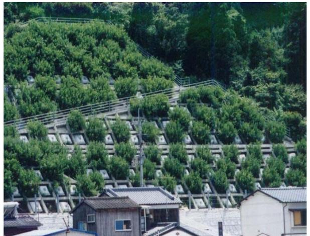
フィットフレームSタイプ施工例
