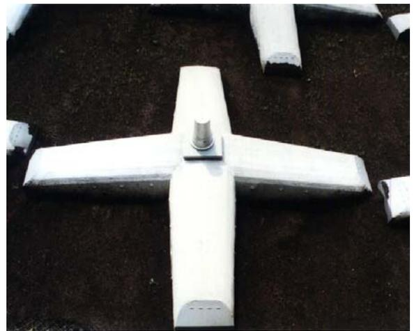
フィットフレームNタイプ施工例
