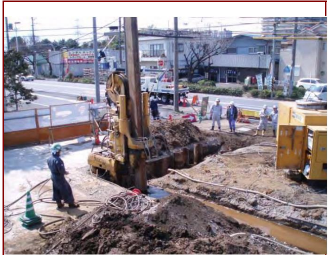
ジェットシートパイル打設状況
