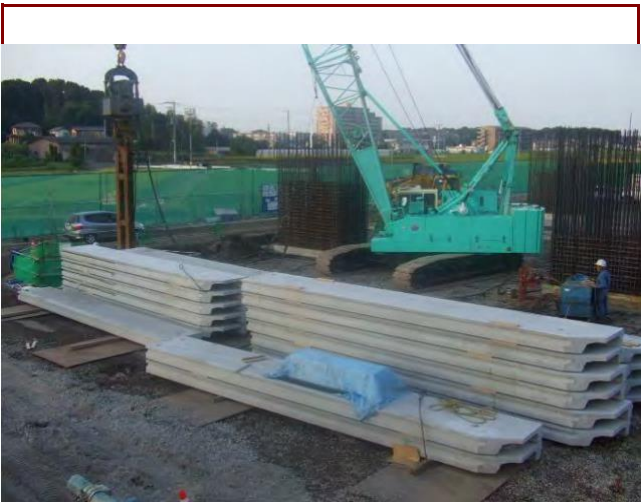
コンクリート矢板打設状況
