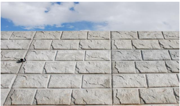
安曇野市発注工事(道路復旧工事)
