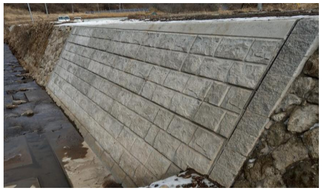
松本建設事務所発注工事(河川災害復旧)
