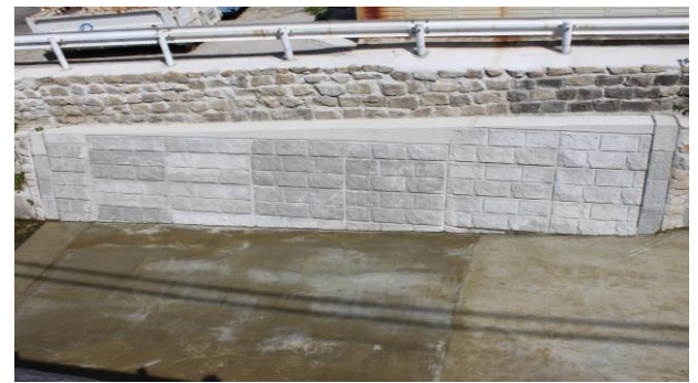
池田町発注工事(河川改修)
