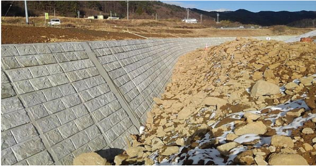
長和町役場発注工事(災害復旧)
