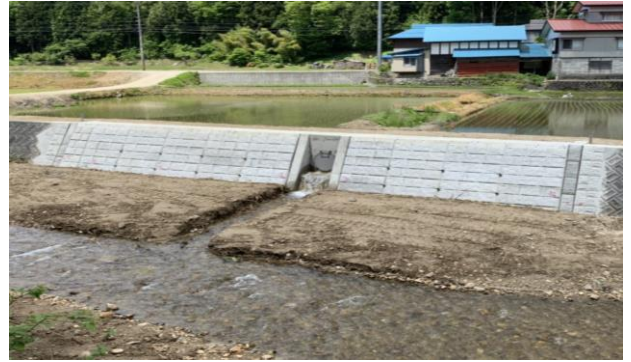
山形県発注工事(河川災害復旧)
