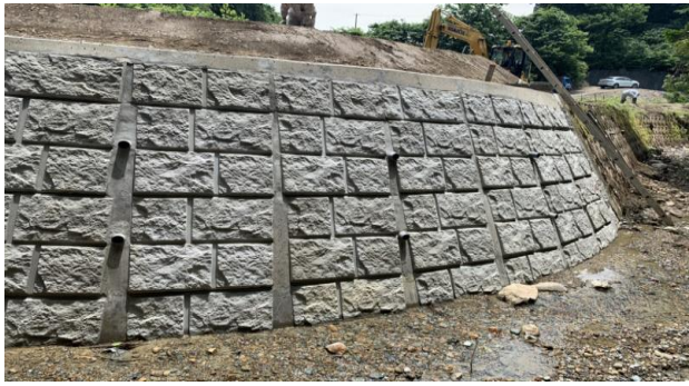
山形県発注工事(河川災害復旧)
