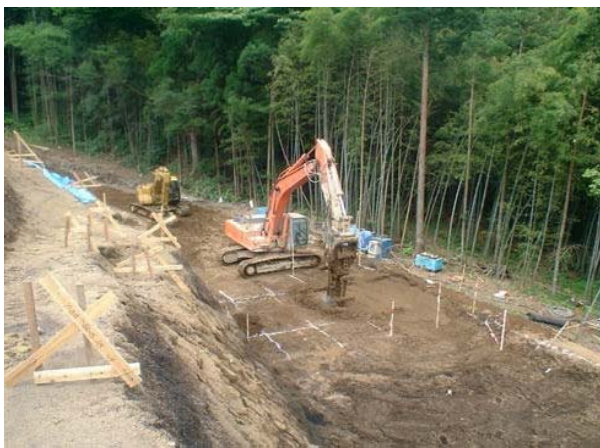
混合攪拌状況
