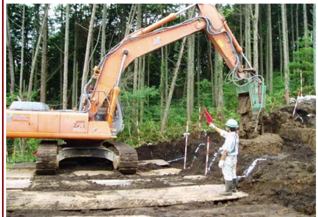
混合攪拌状況
