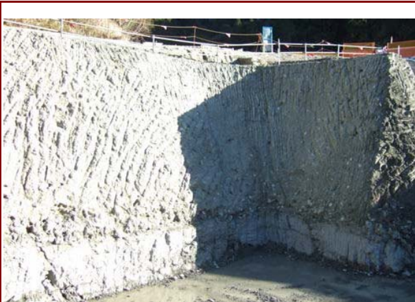
土留改良 掘削断面
