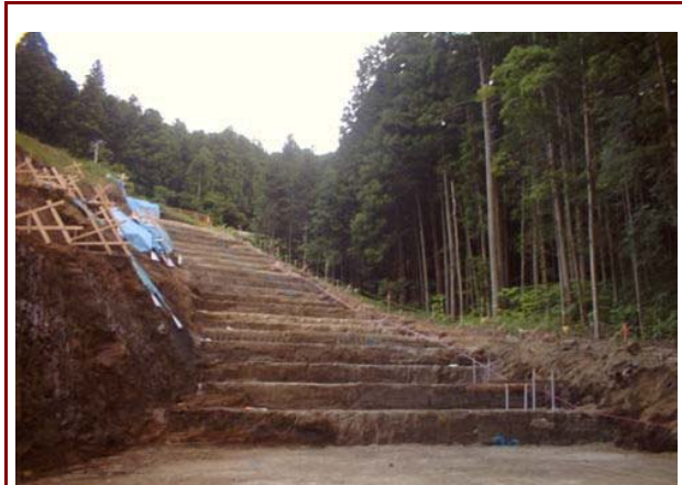
補強土壁基礎 施工完了
