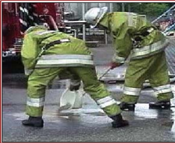
【施工②】本製剤散布、混合・吸収
