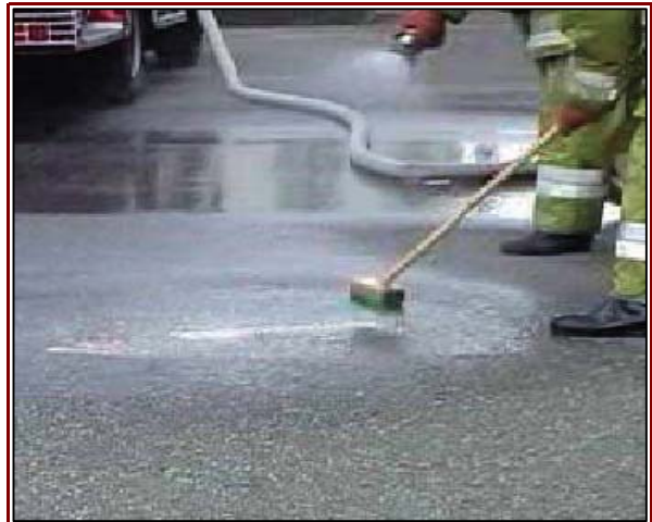
【施工①】中和剤(乳化剤)と水を散布、混合
