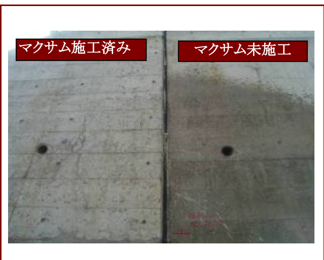
コンクリート擁壁にマクサム塗布後水掛比較写真
