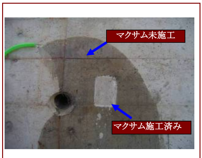
コンクリート擁壁にマクサム塗布後水掛比較写真
