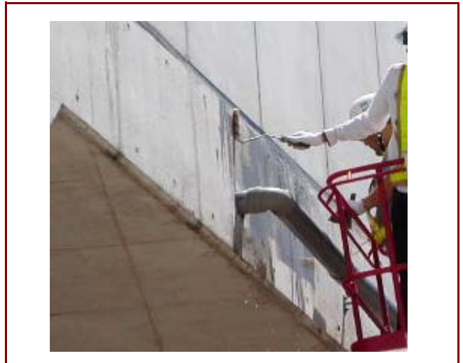
マクサム表面改質工法塗布写真
