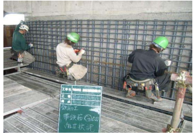
補強鉄筋取付工
