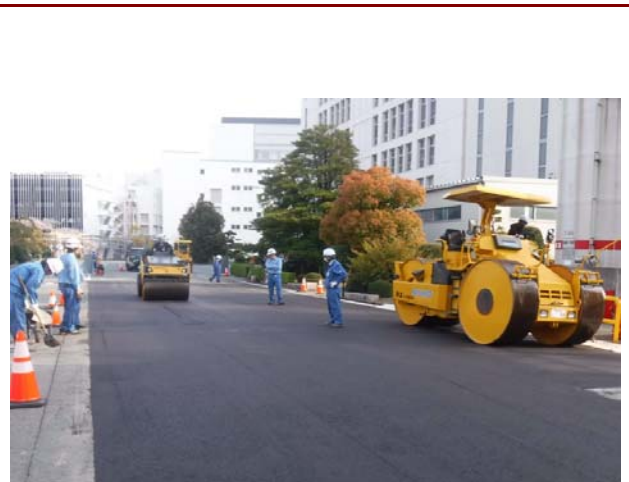
舗設状況 (改質Asと同じ)
