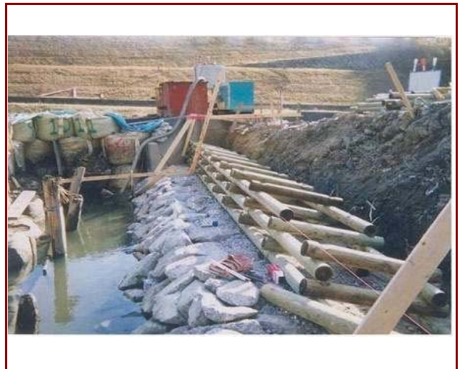
護岸工施工例
